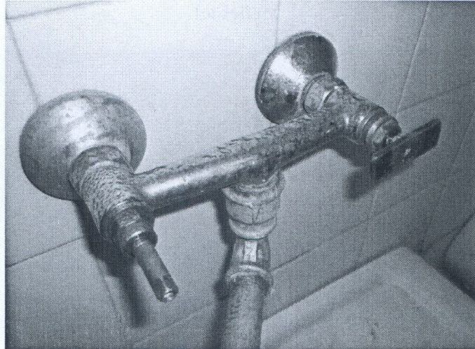
4. kép: balesetveszélyes, hegyes csap
