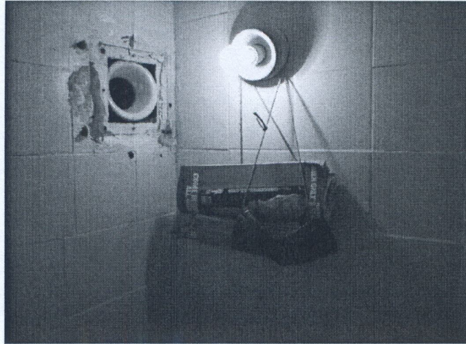
19. kép: a szellőző hiányos borítása
